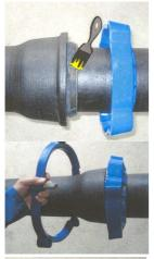
Placer le jonc contre le front de l'emboîtement et lubrifier le jonc.
