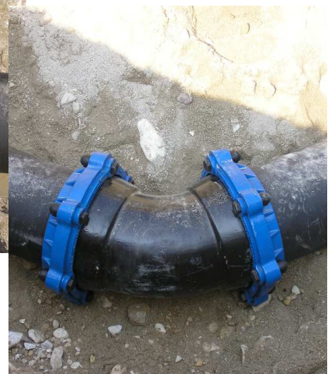
Montage Aussenliegende Schubsicherung Typ BMH 003
